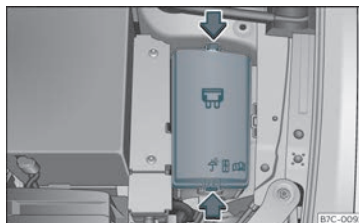
Fig. 47 No compartimento do motor: tampa da caixa de fusíveis.
